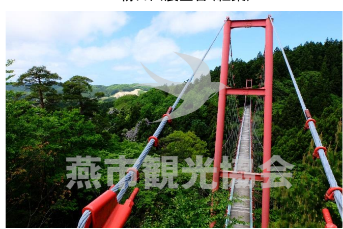
千眼堂吊り橋②
