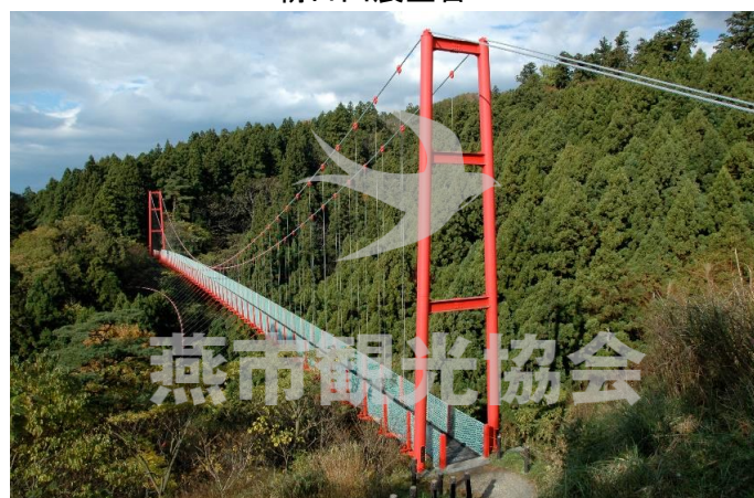
千眼堂吊り橋①
